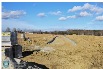
Budowa ulicy Brzozowej w Kolbuszowej
