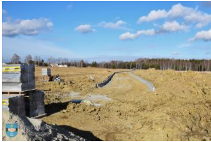
Budowa ulicy Brzozowej w Kolbuszowej
