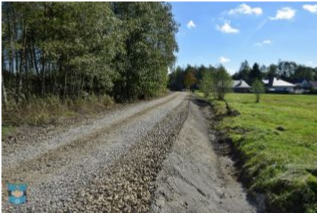
Trwa przebudowa drogi gminnej Domatków-Zagranicze
