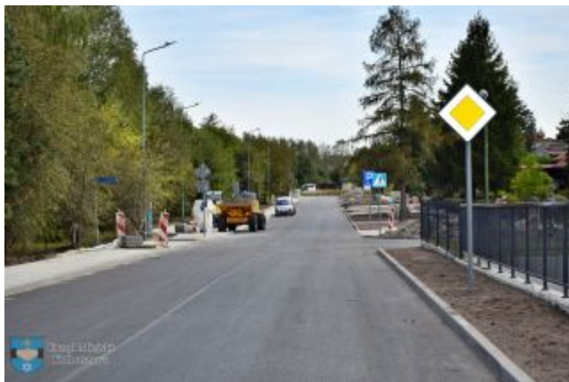
Przebudowa ul. 3 Maja na ukończeniu
