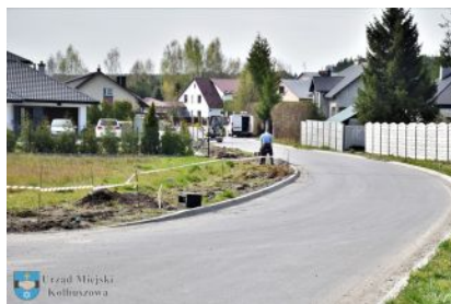
Rozbudowa ul. Piaskowej
