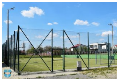
Oświetlenie boiska sportowego w Kupnie
