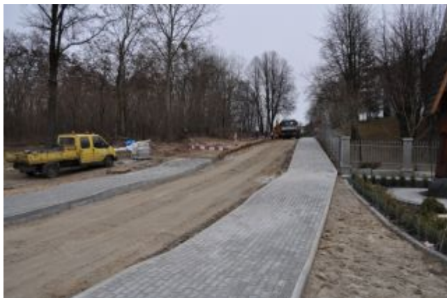
Budowa chodnika w miejscowości Kupno
