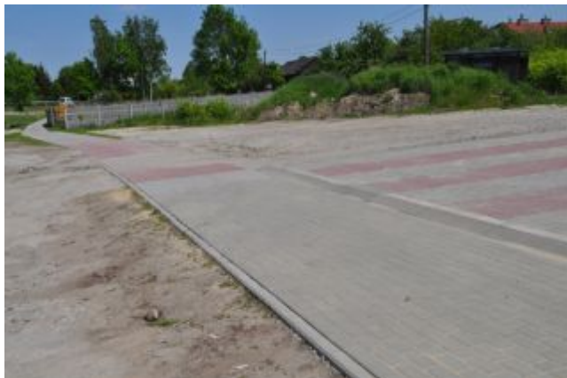
Budowa chodnika w miejscowości Kupno
