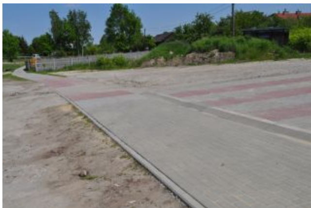
Budowa chodnika w miejscowości Kupno
