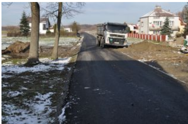
Przebudowa dróg gminnych
