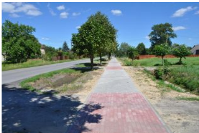
Budowa chodnika w Kupnie
