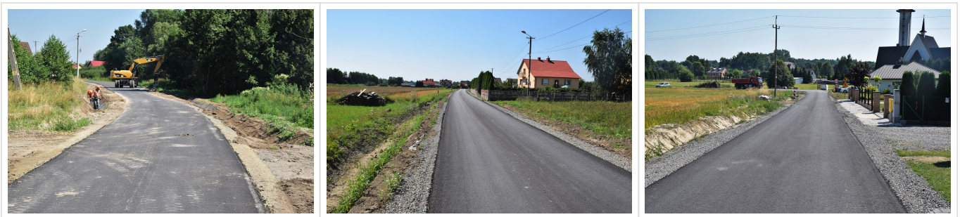
ZADANIE NR 2: Budowa drogi gminnej ulicy Brzozowej w Kolbuszowej wraz z infrastrukturą towarzyszącą.
