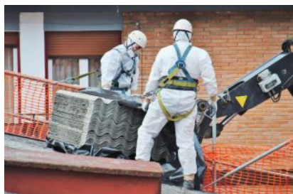
Odbiór odpadów zawierających azbest
