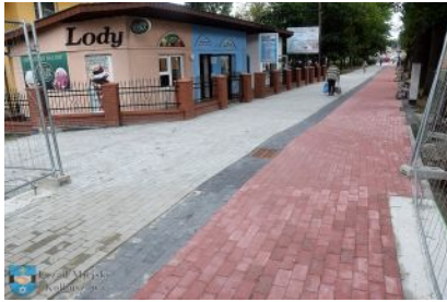
Przebudowa ul. Parkowej
