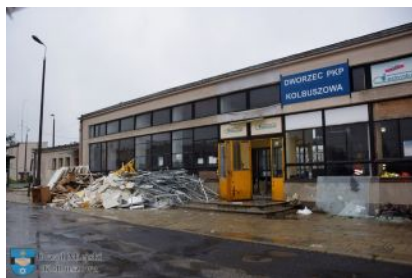
Prace przy przebudowie dworca w Kolbuszowej
