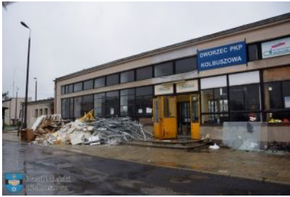
Prace przy przebudowie dworca w Kolbuszowej
