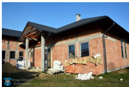
Budowa remizy OSP w Świerczowie
