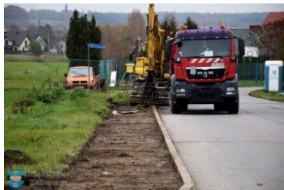
Budowa chodnika przy ul. M. Siedmiograj
