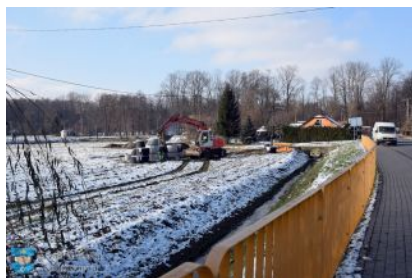
Budowa kanalizacji sanitarnej w Weryni- etap I
