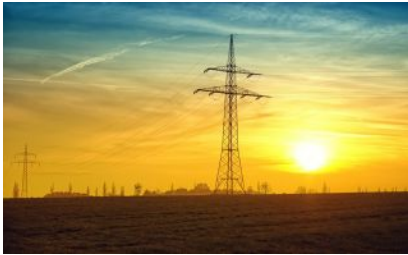
Wymiana przewodów odgromowych na linii elektroenergetycznej 400 kV Połaniec-Rzeszów
