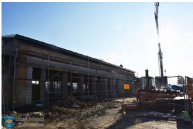
Przebudowa budynku dworca w Kolbuszowej
