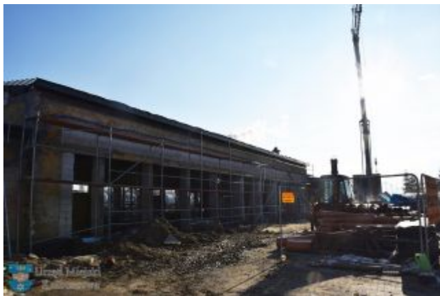
Przebudowa budynku dworca w Kolbuszowej
