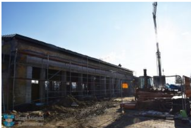
Przebudowa budynku dworca w Kolbuszowej
