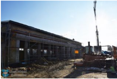
Przebudowa budynku dworca w Kolbuszowej
