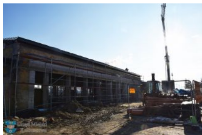
Przebudowa budynku dworca w Kolbuszowej
