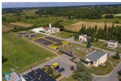
Rozbudowa oczyszczalni ścieków
