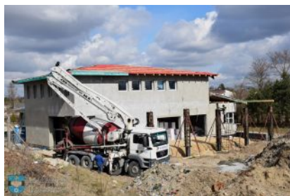
Budowa Dziennego Domu Seniora
