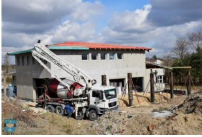
Budowa Dziennego Domu Seniora
