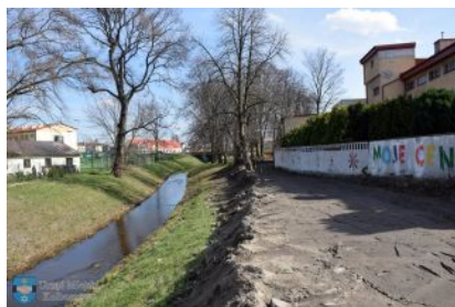
Budowa bulwarów nad Nilem
