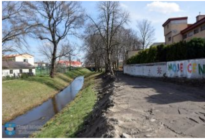
Budowa bulwarów nad Nilem
