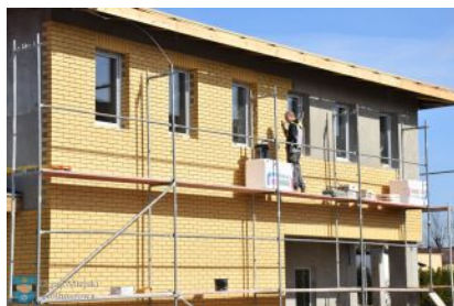
Budowa Dziennego Domu Pobytu Seniora
