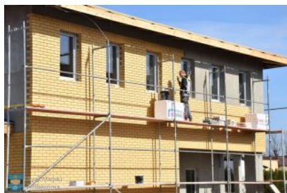
Budowa Dziennego Domu Pobytu Seniora
