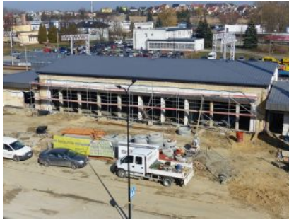
Trwa przebudowa dworca
