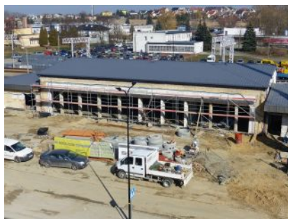
Trwa przebudowa dworca
