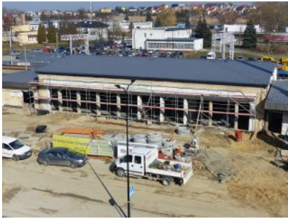
Trwa przebudowa dworca
