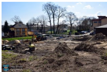
Prace przy budowie bulwarów
