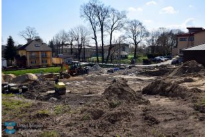
Prace przy budowie bulwarów
