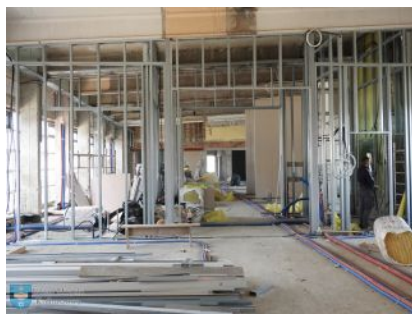
Przebudowa budynku dworca
