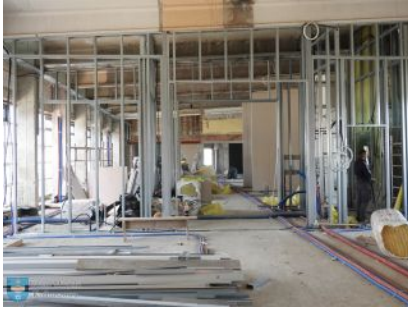
Przebudowa budynku dworca
