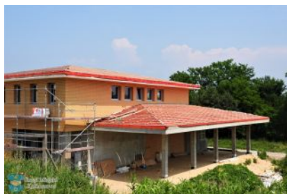
Trwa budowa domu seniora
