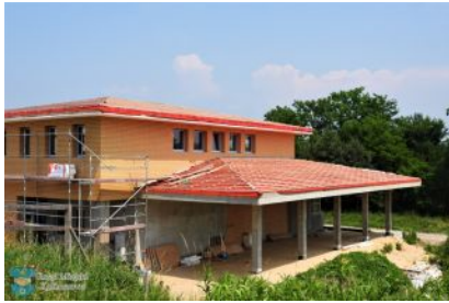
Trwa budowa domu seniora
