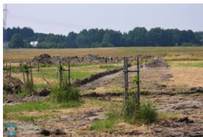
Budowa Parku Niepodległości
