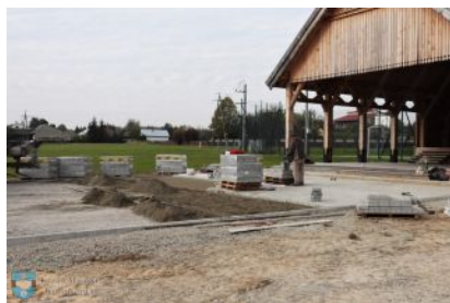
Utwardzenie placu przy scenie plenerowej w Kupnie
