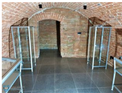
Remont krypty w kościele pw. Wszystkich Świętych
