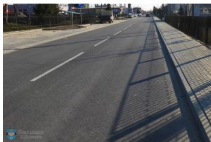
Ul. Handlowa przebudowana
