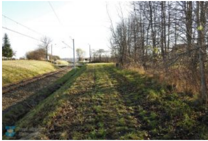
Budowa parkingu wraz z dojściem do przystanku kolejowego w Kolbuszowej Górnej
