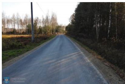
Modernizacja drogi dojazdowej w Nowej Wsi
