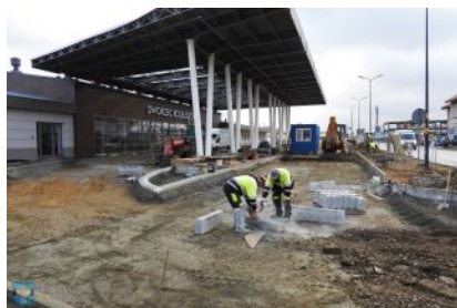
Budynek dworca w przebudowie
