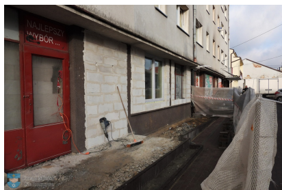
Przebudowa pomieszczeń w budynku przy ul. Piłsudskiego
