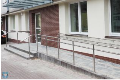
Przebudowa pomieszczeń w budynku przy ul. Piłsudskiego
