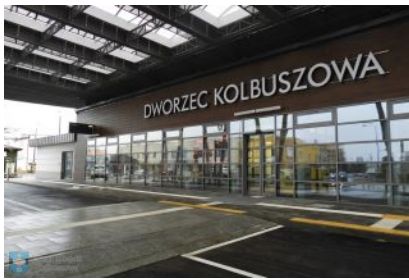
Nowoczesne centrum przesiadkowe w Kolbuszowej
