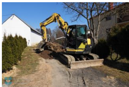
Budowa kanalizacji sanitarnej w Weryni
