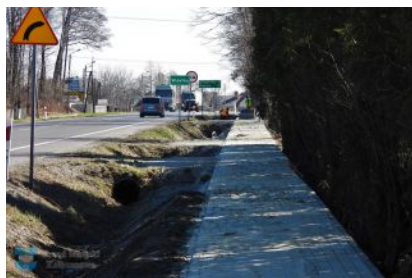
Budowa chodnika w miejscowościach Kupno i Widełka
