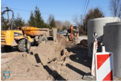
Roboty budowlane na ul. Kolejowej
