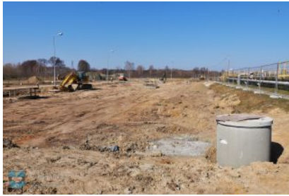
Rozbudowa oczyszczalni ścieków w Kolbuszowej Dolnej
