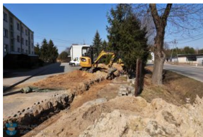
Prace kanalizacyjne przy blokach na ul. Wolskiej
