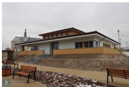
Nowy nabór na stanowisko rehabilitanta w DDPS
