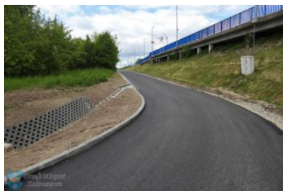
Prace przy przystanku kolejowym w Widelce
