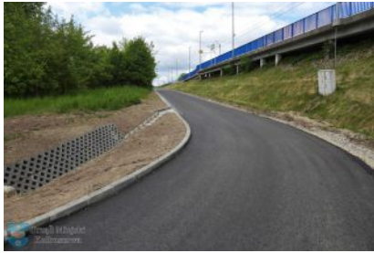
Prace przy przystanku kolejowym w Widelce
