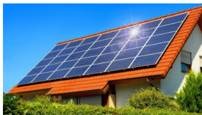
Instalacje fotowoltaiczne - realizacja dodatkowego zadania
