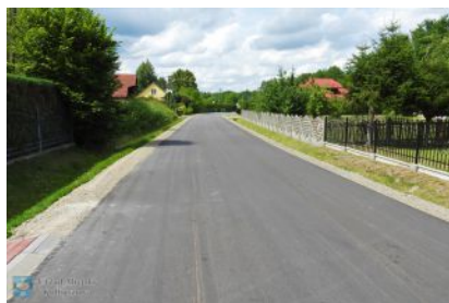
Przebudowa drogi gminnej w Świerczowie
