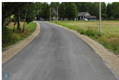
Przebudowa drogi gminnej Nowa Wieś - Borek
