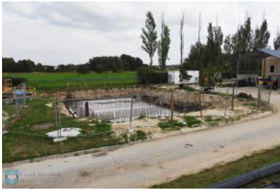
Rozbudowa i modernizacja oczyszczalni ścieków w Kolbuszowej Dolnej
