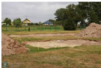
Teren pod budowę nowego miejsca rekreacji w Kupnie
