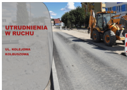
Utrudnienia w ruchu - ul. Kolejowa
