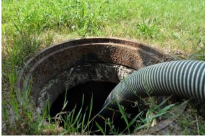
Kontrola zbiorników bezodpływowych i przydomowych oczyszczalni ścieków
