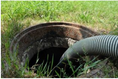
Kontrola zbiorników bezodpływowych i przydomowych oczyszczalni ścieków
