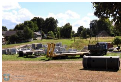
Prace kanalizacyjne w Weryni
