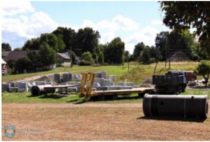
Prace kanalizacyjne w Weryni
