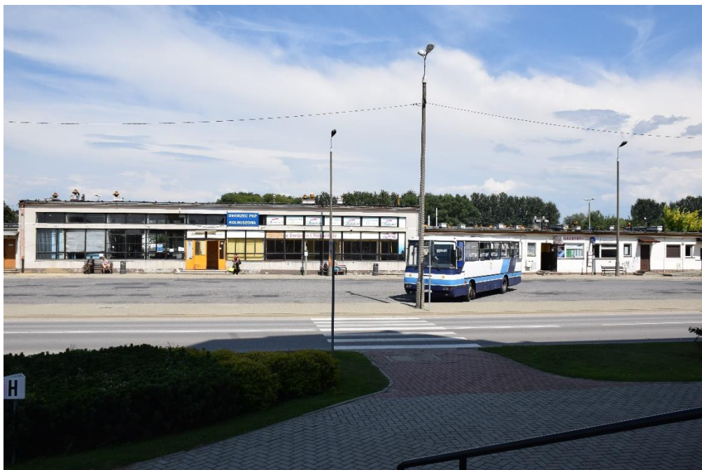
Fotografia 12 Zdegradowany budynek Dworca PKP
