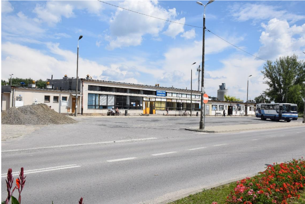
Fotografia 11 Zdegradowany budynek Dworca PKP
