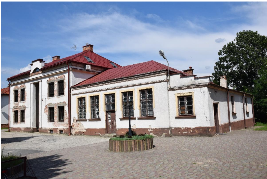
Fotografia 6 Zdegradowany budynek "Katechetówki"
